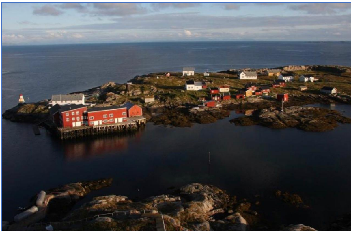
Figur 38: Brygga på Halten (på kaia der hurtigbåten legger til, i første etasje var det gamle fiskemottaket (i dag lagerrom og et maritimt innredet rom med langbord i bruk i forbindelse med fester og konferanser) i 2. etasje er det festsal, soverom, dusj og toalett. Her finnes også Halten Handel. I 3. etg er det stort kjøkken, bad, soverom og stue) Bygningsmassen har 3 etasjers høyde. (Kilde: https://www.ovrekka.no/opplevelser-halten-froya/ ).
