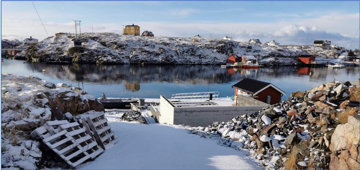
Figur 20: Foto av eksisterende situasjon sett fra adkomstveg mot sør (Foto: Johnny B. Gaarden).
