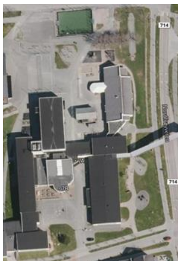
Oversiktsbilde av skolen, bygninger og uteområde
